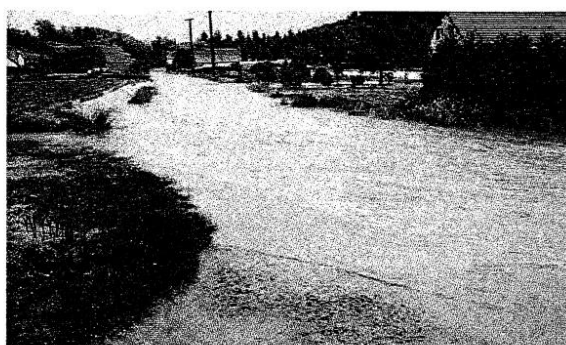
Après l'orage du 03/06/1992, à Sélens... Source Mairie
